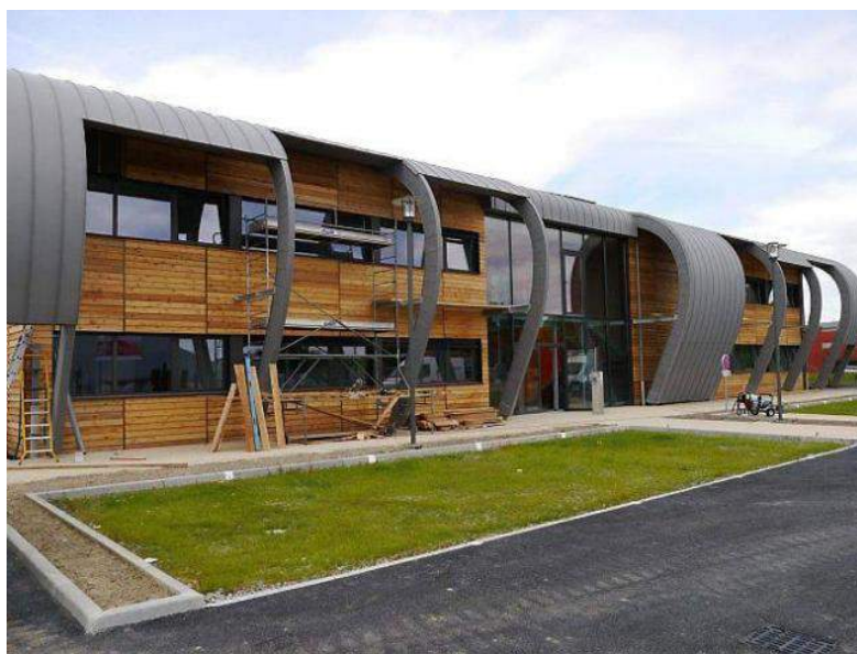
Figure 105 : Bâtiment BBC SYNERGY8 à Dol-de-Bretagne (Source : Ouest-France)
