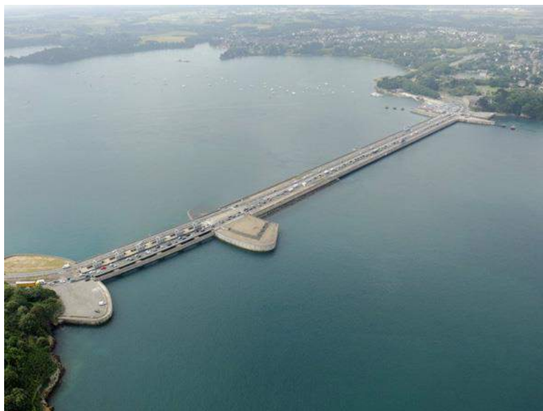
Figure 152 : L'usine marémotrice de la Rance (Source : EDF)
