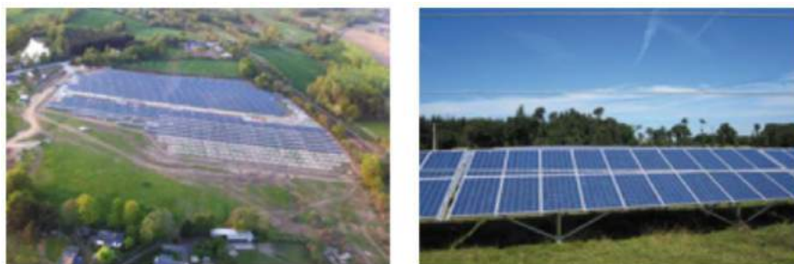
Figure 132 : Centrale photovoltaïque au sol de La Fresnaie à Bonnemain (Source : Mairie de Bonnemain)
