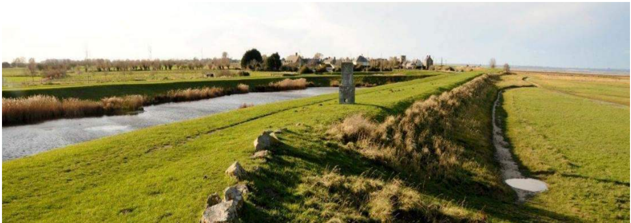
Figure 174 : Digue de la Duchesse Anne (Source : Rapport PPRL 2014)
